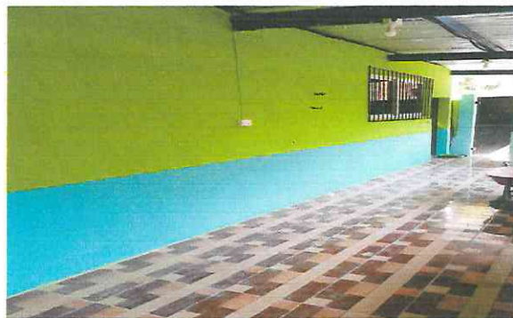
Foto 2: reparación de repello, cernido y pintura en paredes interiores y exteriores
