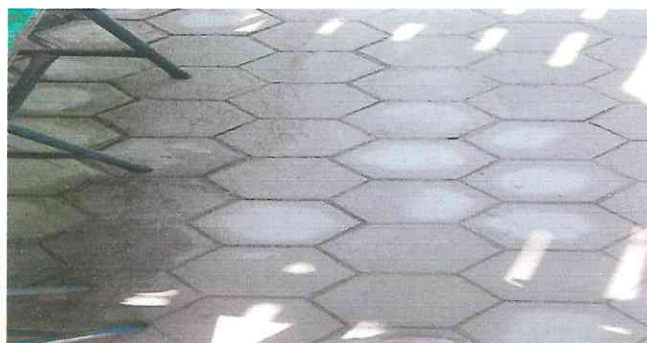
Foto 4: reparación de planchas de concreto en el área de baños
