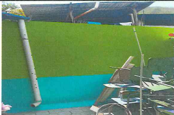
Foto 1: reparación de repello, cernido y pintura en paredes interiores y exteriores de todo el establecimiento
