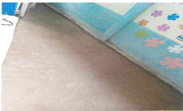
Foto 3: reparación de planchas de concreto por losa de patio
