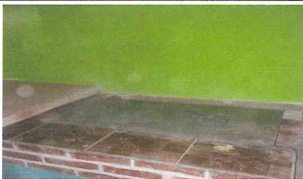
Foto 5: Sustitución de plancha de metal
